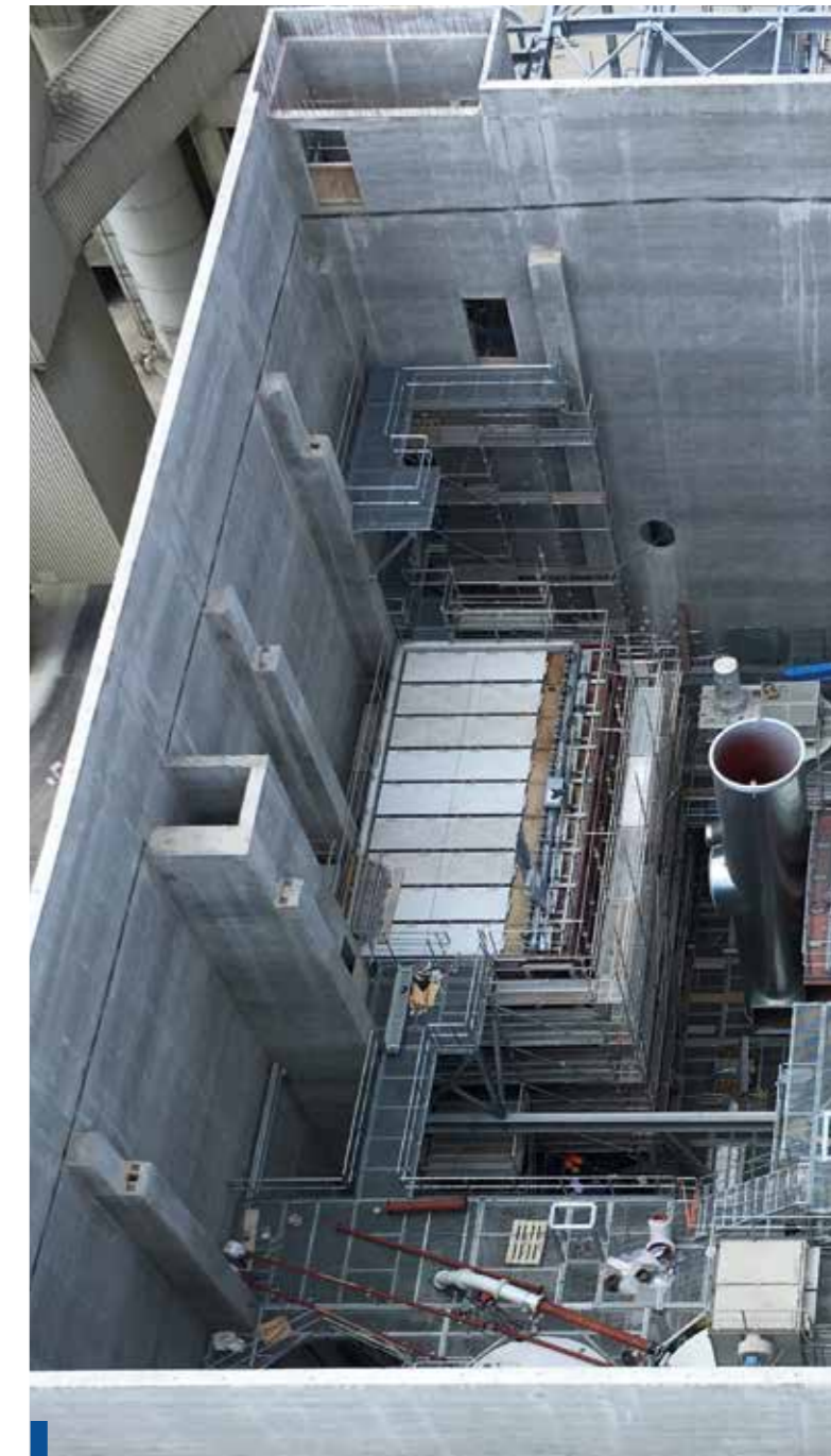
Blick von oben in die neue Mahlanlage bevor der „Deckel“ montiert wurde
